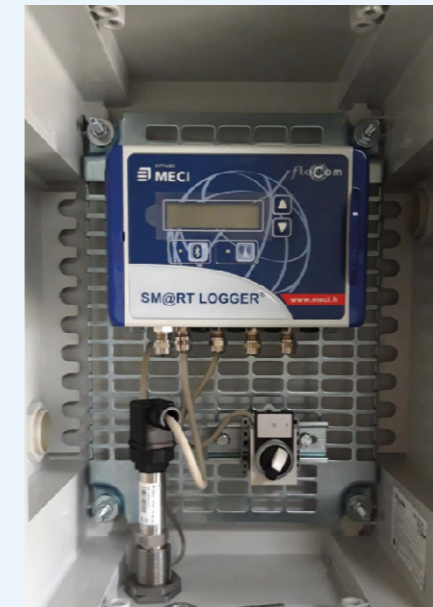
L'analyse des données des systèmes numériques enregistrant les mesures de pression dans les postes de détente permet d'anticiper certaines opérations de maintenance.
