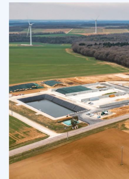
Optimiser l'apport en O 2 nécessaire à la désulfuration du biogaz dans le méthaniseur, en s'appuyant à la fois sur l'intelligence artificielle, la modélisation numérique et le contrôle prédictif avancé.
