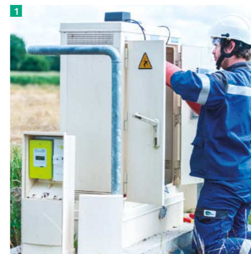
1 Intervention sur coffret électrique
