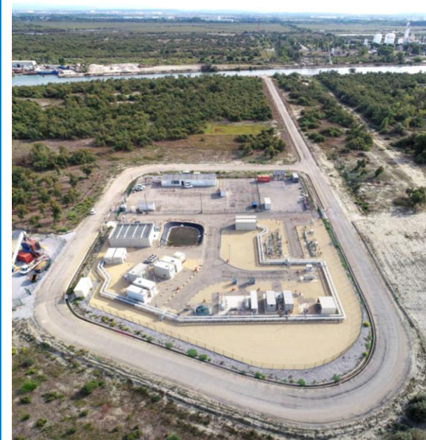
Démonstrateur Power to gas Jupiter 1000
