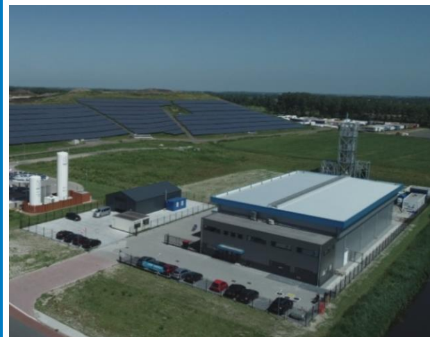
Site de Gazéification hydrothermale en NL
