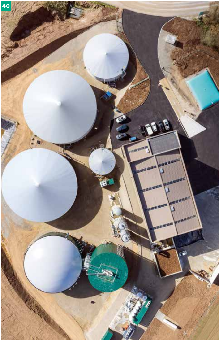
Poste de biométhane à Chateaulin / Photo © GRTgaz / Pascal Léopold
